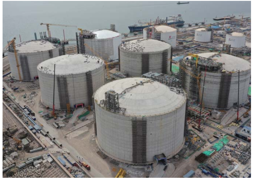
□ Tianjin LNG Phase II Receiving Terminal Project
