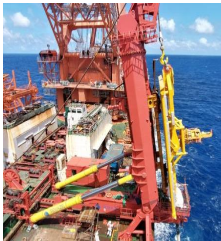
整体式管道终端船侧安装 PLET J-mode Installation
